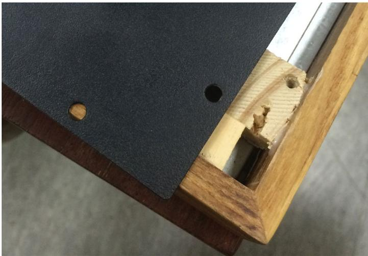
Montaje de la placa de acero en la estructura con tornillos
